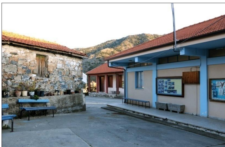
Φωτογραφία 29: Παλαιό και νεότερο κτίριο δημοτικού, Πηγή: Αυγουστίνος Δημητρίου
